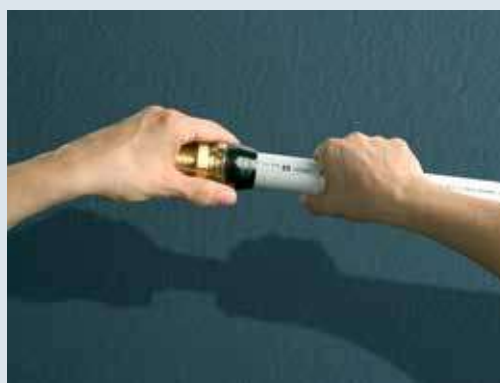
Joonis 9-3: Press-fitting ilma tööriistata.
